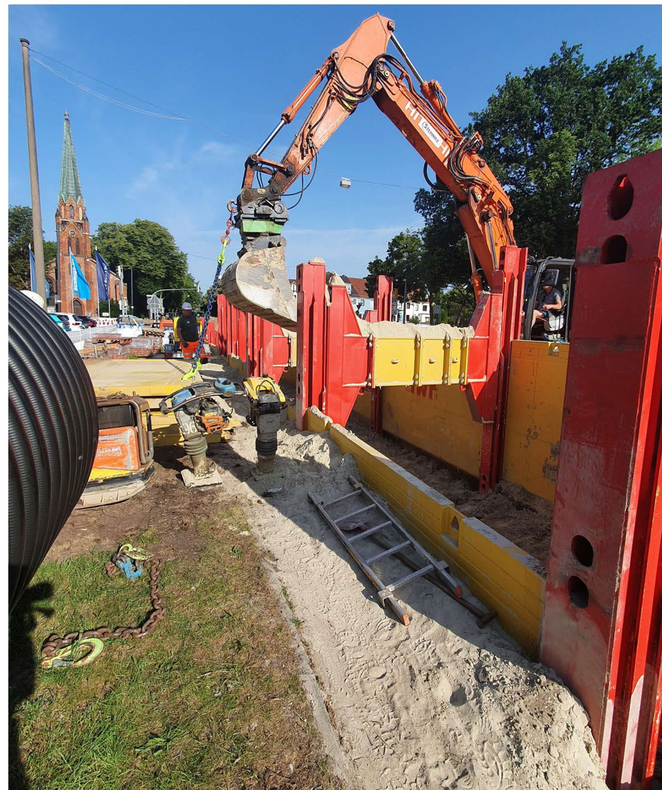
Der eigentliche Kanalbau in der Bennigsenstraße begann im Juni 2022 ab der Kreuzung Stresemannstraße (Bauabschnitt 1) und wurde ab Mitte Juli von einer zweiten Kolonne in der Stresemannstraße in Richtung Steubenstraße unterstützt (Bauabschnitt 2).
