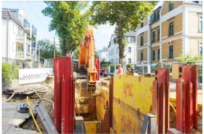
Auch auf der Windbergstraße erneuert die DREWAG die wichtige Wassertrasse.
